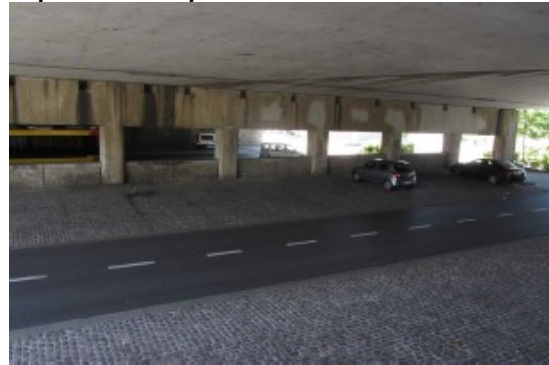
Espace sous le pont de la A604.
