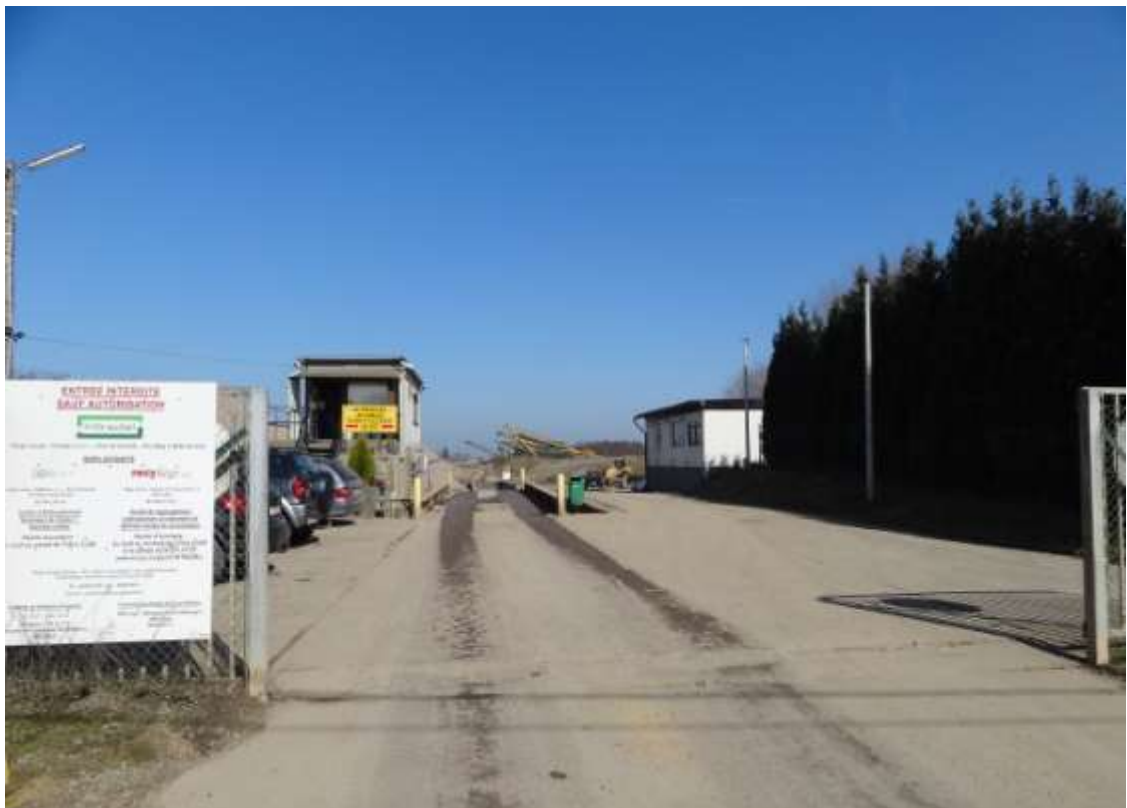
Entrée du C.E.T. de ROSSART
