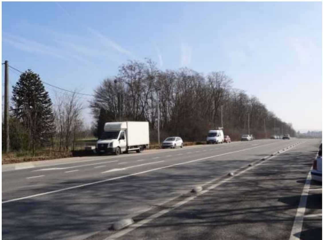
Partie Haute de la N677 : vue vers le Sud. A gauche la sous-zone de Rossart. A remarquer la zone de stationnement en bordure la route régionale et la zone végétale tampon.
