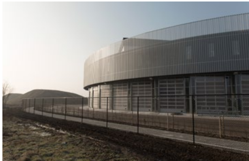
LA CASERNE DES POMPIERS DE LA ZONE DE SECOURS HAINAUT EST ARCHITECTURE/INGÉNIERIE : PHILIPPE SAMYN AND PARTNERS, ARCHITECTES ET INGÉNIEURS AVEC RESERVOIR A, FLOW TRANSFERT INTERNATIONAL BUREAU MEIJER ET NEO & IDES IMAGE : ETIENNE ZAJEGA
