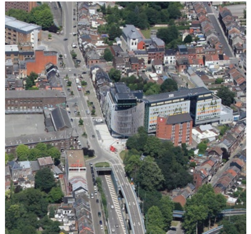
SOLÉO ARCHITECTE : IGRETEC
