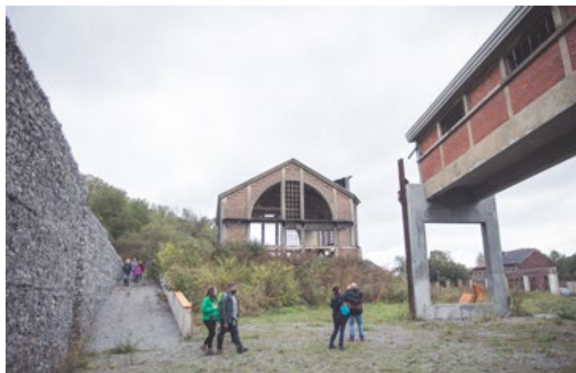
LE MARTINET RÉNOVATION : DESSIN ET CONSTRUCTION PHOTOGRAPHE : LESLIE ARTAMONOW
