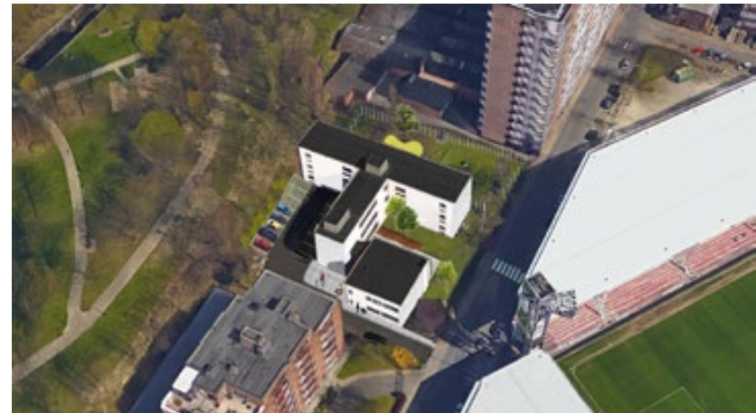
RÉNOVATION DE LA CRÈCHE ACHILLE DOURLET
