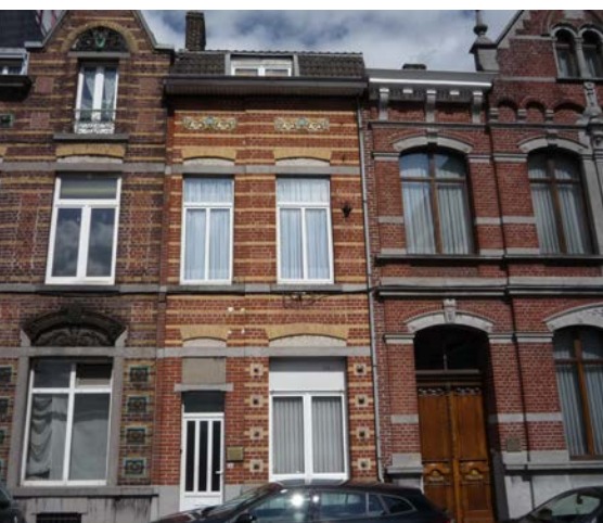
Trois façades à l'intérêt patrimonial certain rue de Montigny dans le centre de Charleroi (Crédit : IEW)
